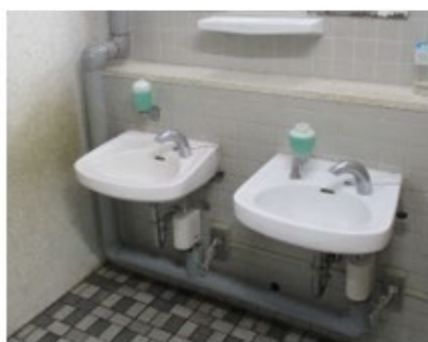
本館棟1階便所 ←
