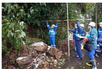
速やかな被災状況調査
