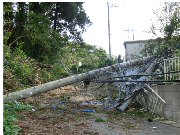
令和元年9月 千葉県山武市 山武市道
