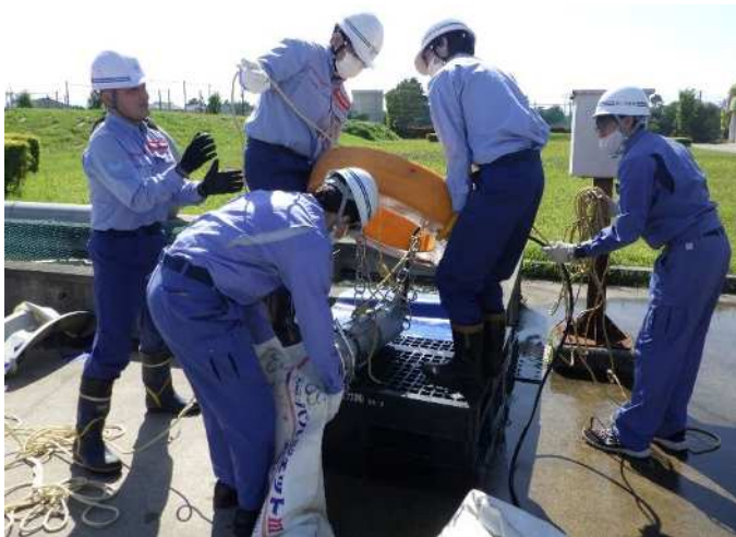
排水ポンプの展開・組立（イメージ）
