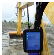
ICT建設機械の施工
