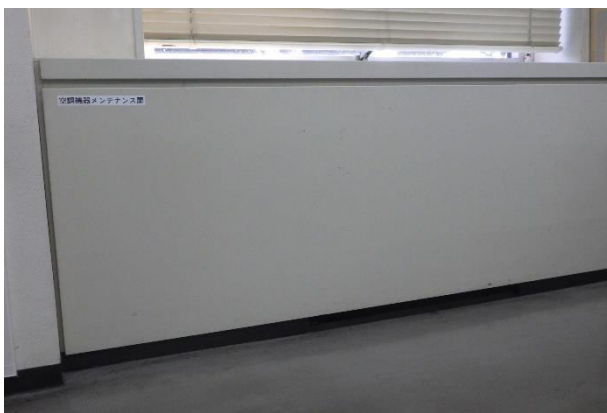
撤去機器（ファンコイルユニット）
