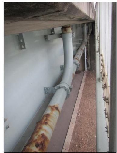
橋梁排水管清掃
