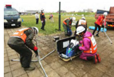
夜間照明用の資機材を組み立て
