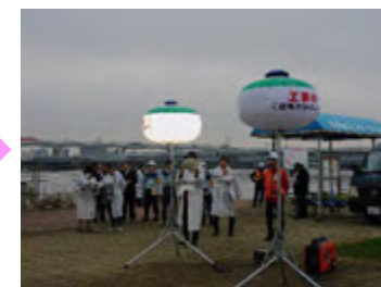
照明設備を点灯
