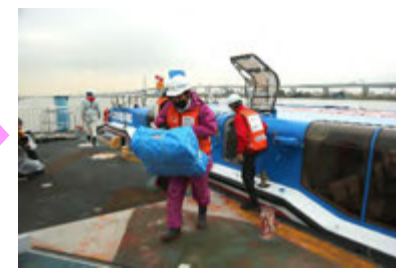
資機材を下ろし、設置場所に運ぶ
