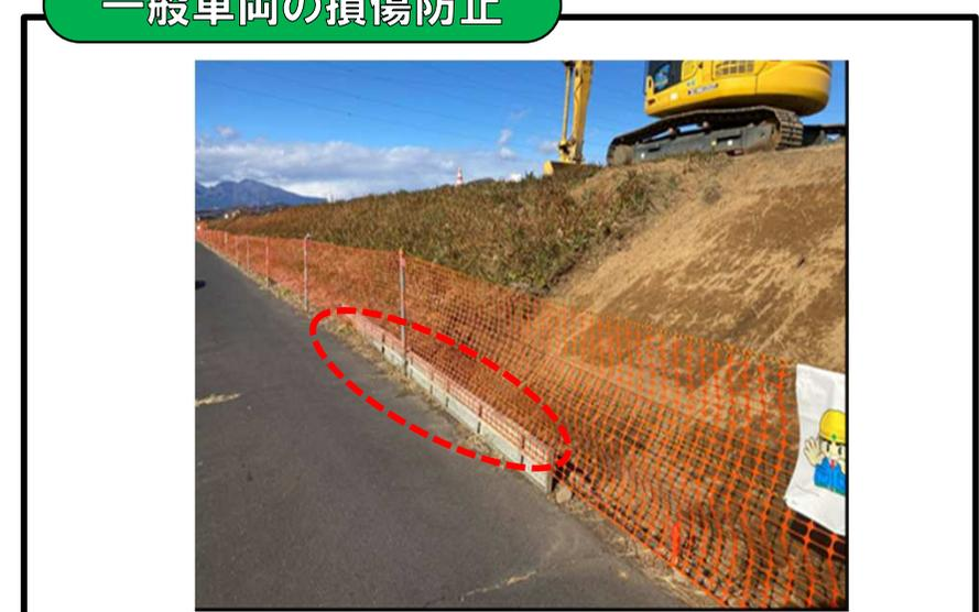
表土はぎ施工時に土砂止板を設置
