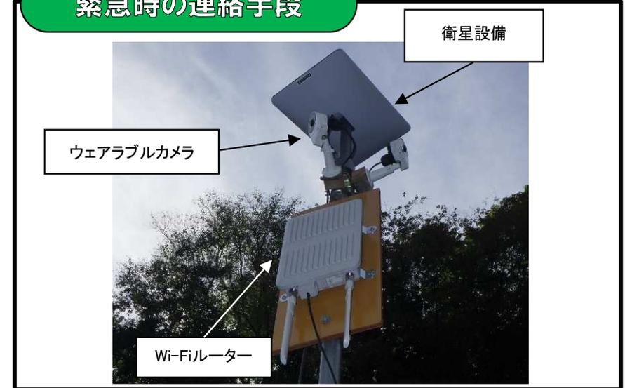
衛星通信設備を設置し、緊急連絡手段を確保
