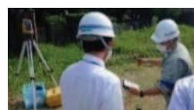
トータルステーション計測
