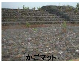
越流堤の構造の例
