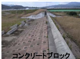
越流堤の構造の例
