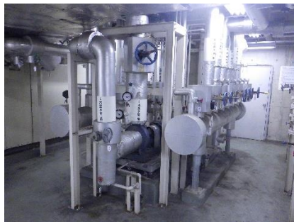
機械室 配管を撤去
