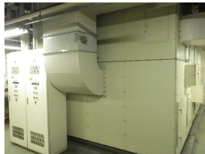
機械室 全熱交換器を撤去
