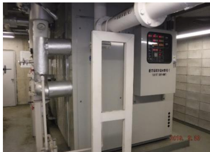
機械室 直焚冷温水機を撤去
