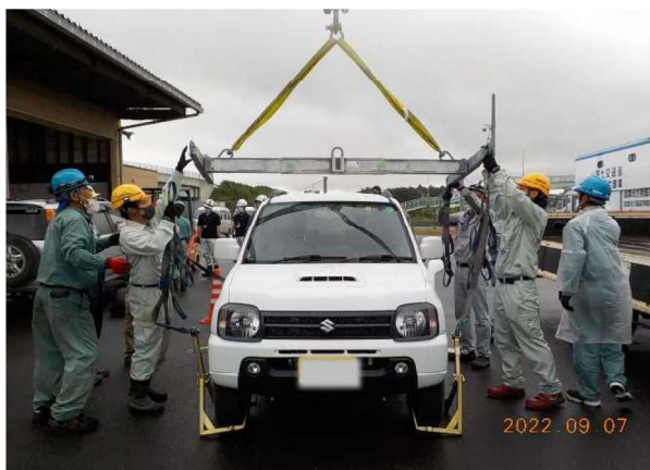
車両移動吊具実施訓練
