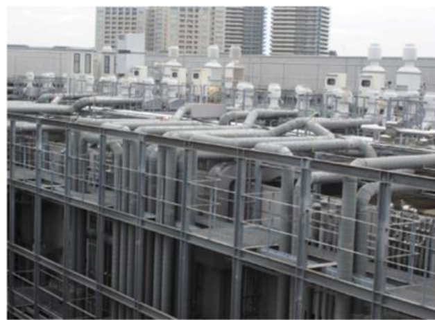
本館実験棟 PH1 階
