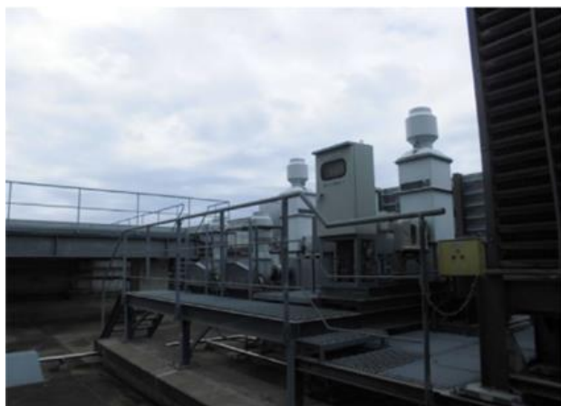
本館実験棟 PH1 階
