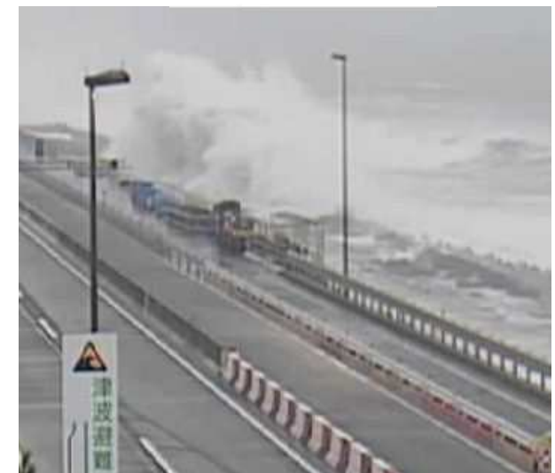
令和元年9月 神奈川県大磯町 国道1号
