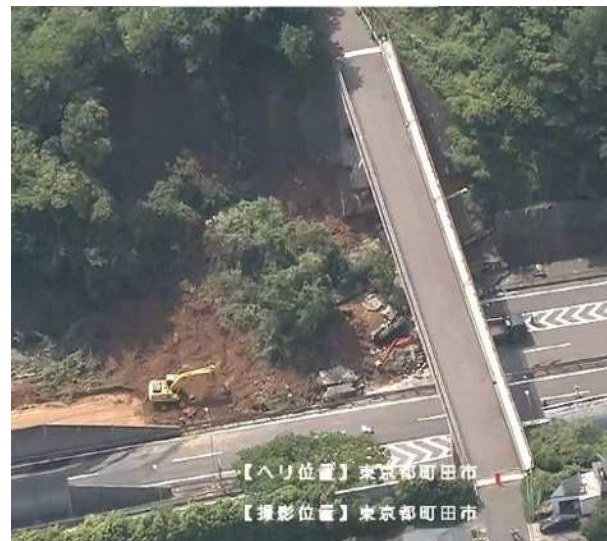
令和5年6月 東京都町田市 国道16号 【ヘリ位置】東京都町田市 【撮影位置】東京都町田市
