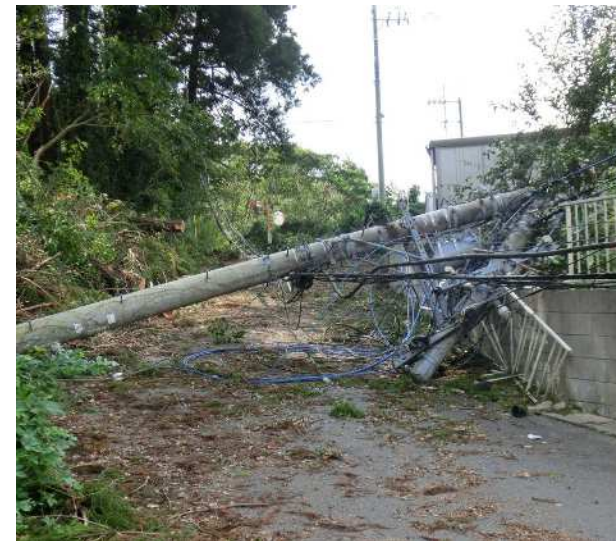
令和元年9月 千葉県山武市 山武市道
