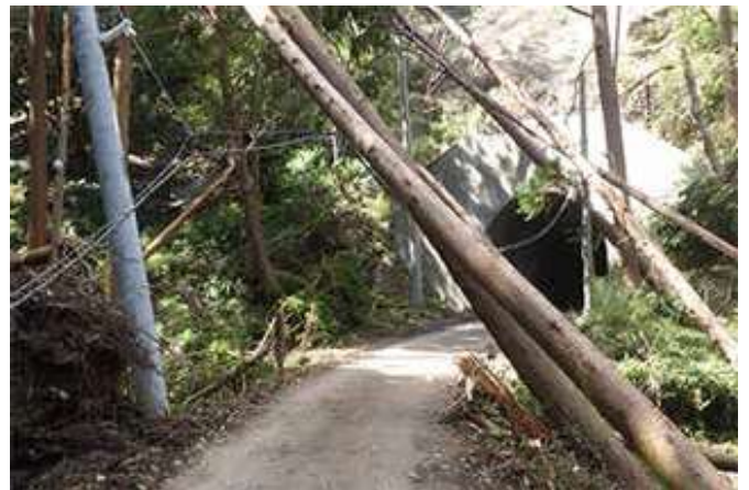
倒壊した電柱・樹木(令和元年台風15号)
