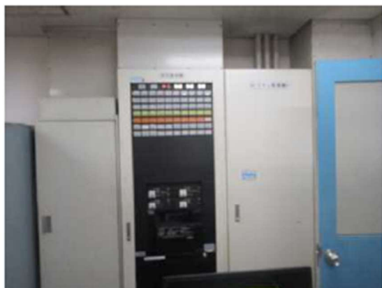
図1 事務庁舎棟（受信機）
