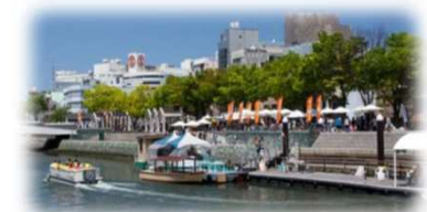
親水護岸の利用 (新町川／徳島市)
