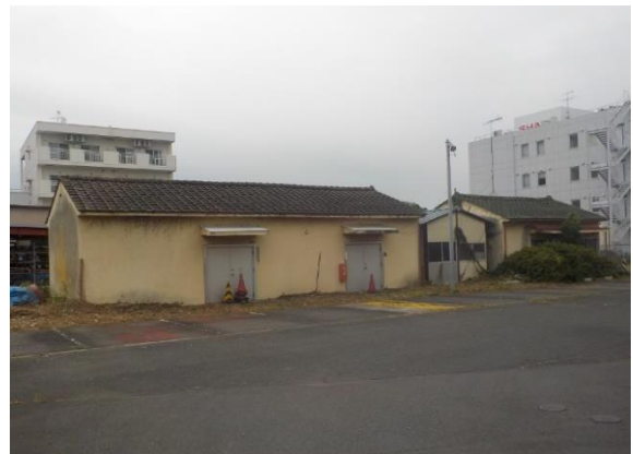
調査対象建物（東西より）
