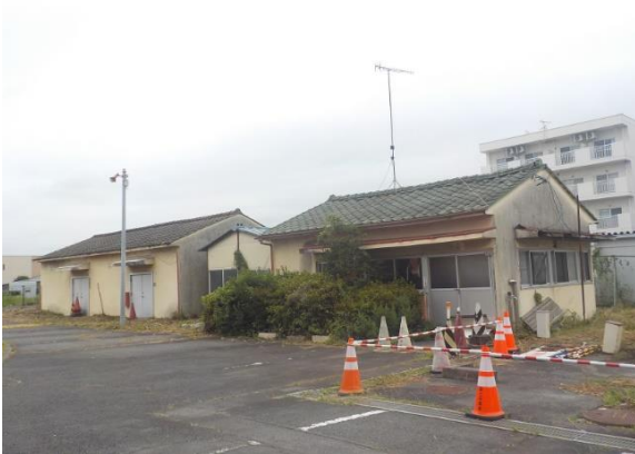
解体建物（南西より）
