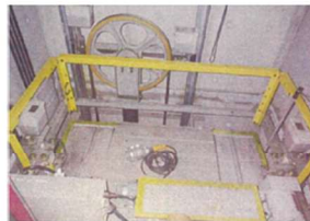
既存エレベーターシャフト内2
