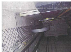
既存エレベーターシャフト内3
