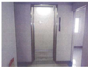
エレベーター正面
