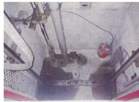
既存エレベーターシャフト内1
