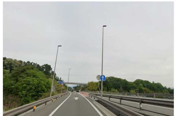
照明灯具交換箇所
