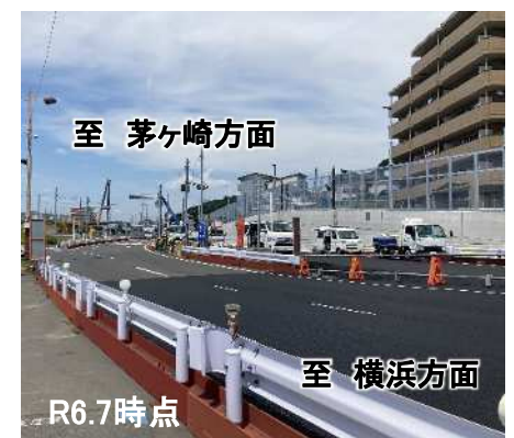
②藤沢IC交差点周辺 工事の状況
