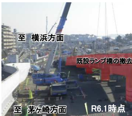
①新湘南バイパス 既設ランプ橋 撤去工事の状況
