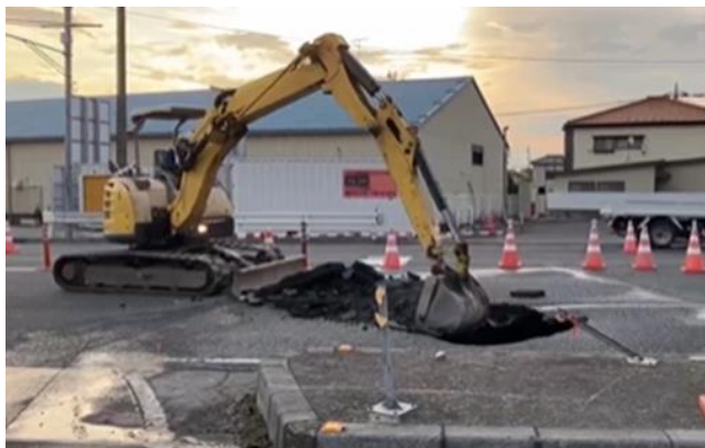
車道掘削状況
