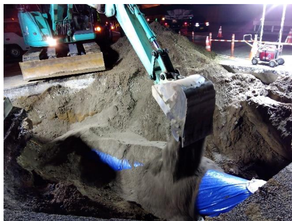
水路管埋戻し状況
