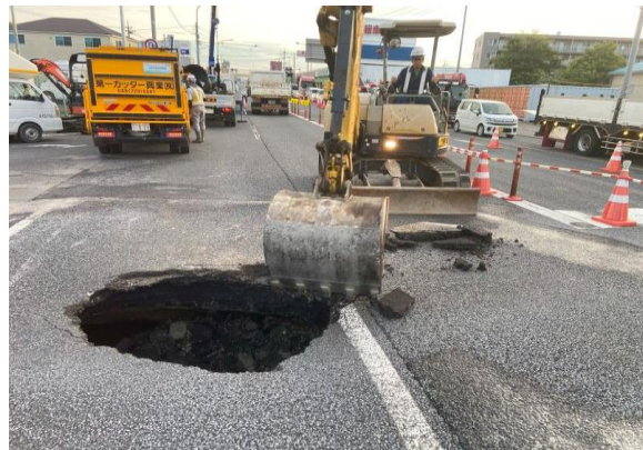
車道掘削状況
