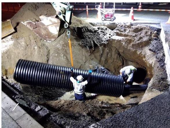
水路管設置状況
