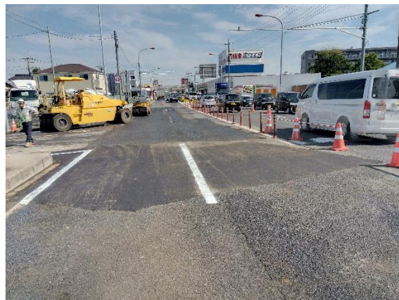
舗設完了状況
