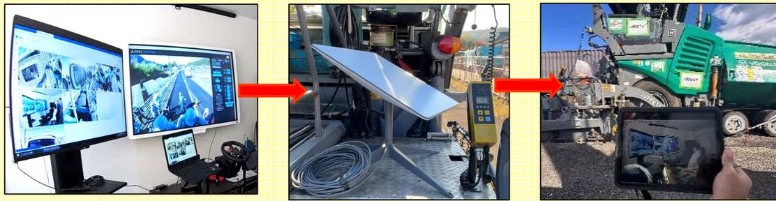
ICT施工のマシンコントロールによるスクリーンの高さ制御のほか、施工幅員と操舵についても自動制御を実施し、全自動化施工に向けて先進的な取り組みであった。
