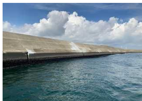
補修完了状況
