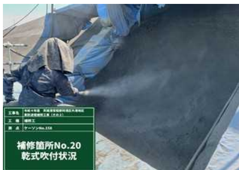
乾式吹付状況
