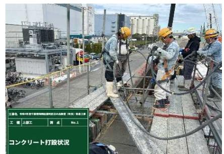
上部工(コンクリート打設)施工状況
