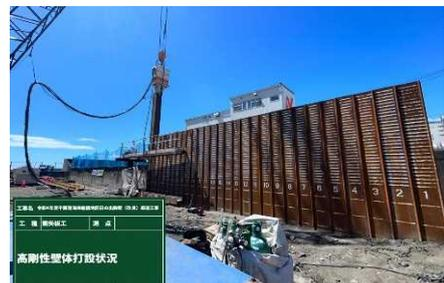
本体工(高剛性壁体打設)施工状況
