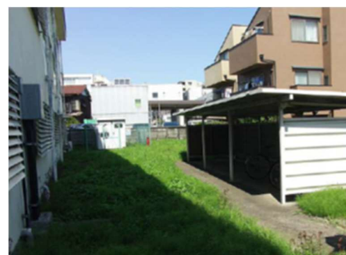
自転車置場、変電設備
