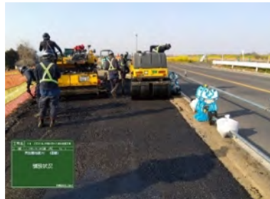
舗装工 施工状況
