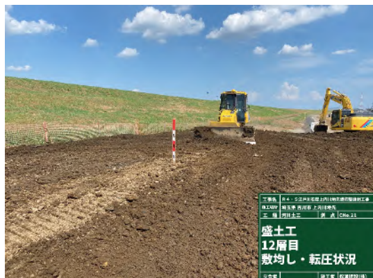
盛土の施工状況
