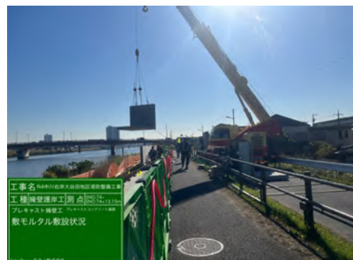
狭小な堤防天端での施工
