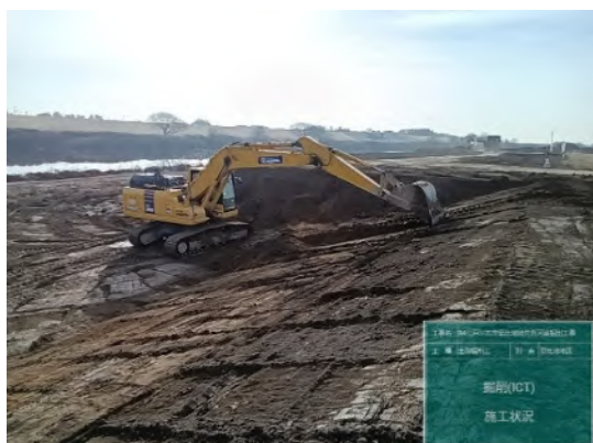
掘削工 施工状況
