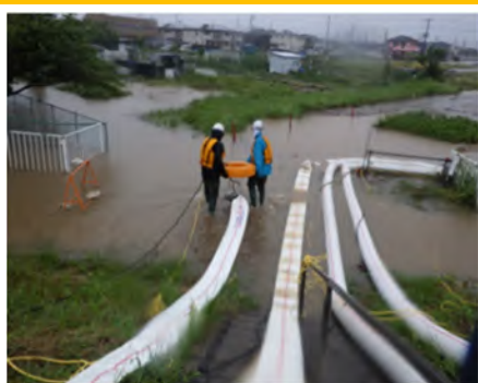
排水ポンプ車のホース設置作業 (松伏町松伏)
