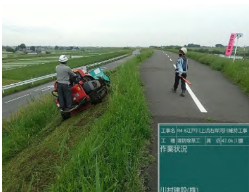
堤防除草施工状況
