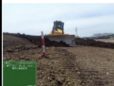
盛土工 施工状況
