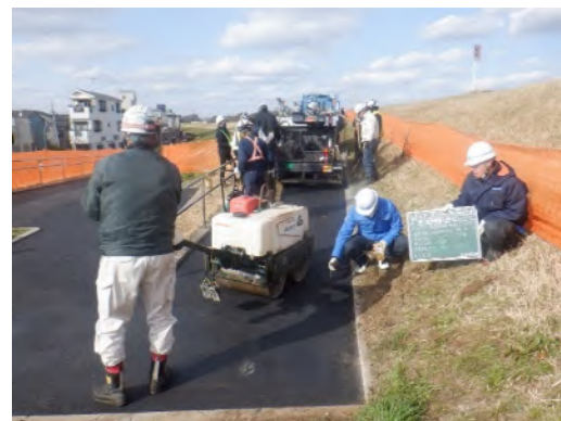
堤防坂路舗装施工状況
