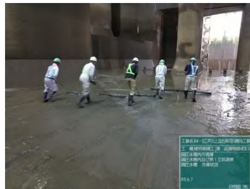
首都圏外郭放水路調圧水槽 土砂撤去施工状況
