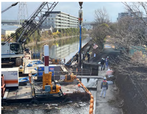
狭小な河道内での水上施工
