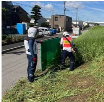
除草状況(飛散防止対策)
