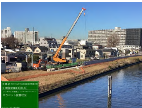
住宅近接部での施工
