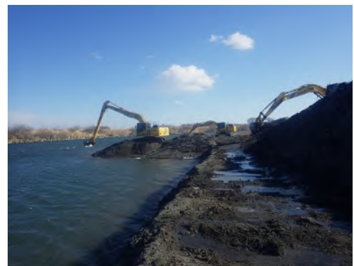
河床堆積土砂撤去施工状況
