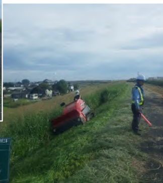
堤防除草施工状況(急傾斜地は遠隔操作草刈機を活用)
