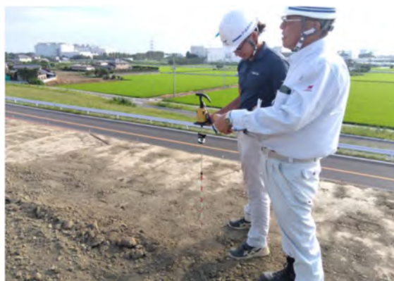
若手技術者による出来形確認
