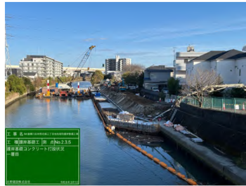
住宅近接部での施工
