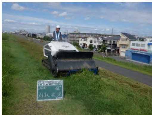
堤防除草施工状況
