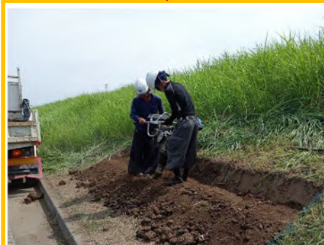
堤防法面崩れの緊急復旧作業 (八潮市木曽根)
