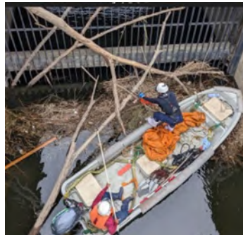
出水後の機橋除塵機流木撤去状況
