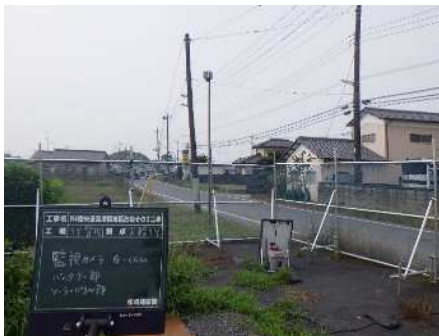
【エコパワーカメラ設置状況】
