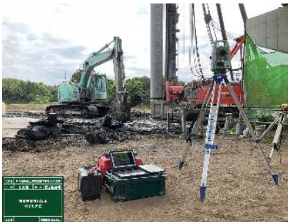
【杭打設管理システムによる施工状況】 【杭心位置をOPに表示したモニター状況】
