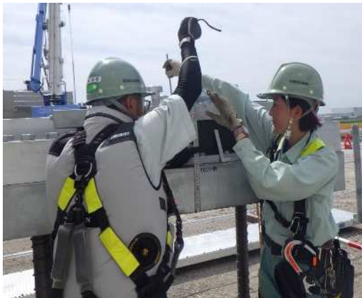
【現場代理人と若手女性技術者による 材料確認状況】
