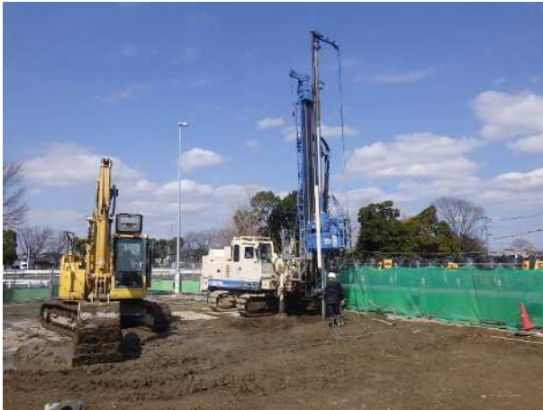
【小型機によるMITS工法（変位低減型）】
