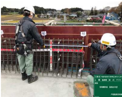
【監理技術者と若手女性技術者による配筋出来形確認状況】
