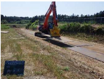
【油圧式敷板鋼板移送装置による敷鉄板設置状況】
