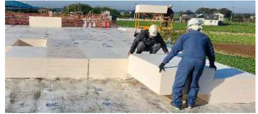
EPS工法は発砲スチロールブロックを人力で積み上げる軽量盛土工法
