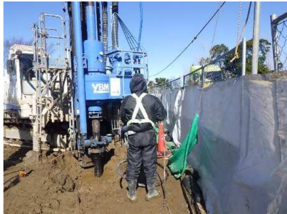
【小型機によるMITS工法（変位低減型）】
