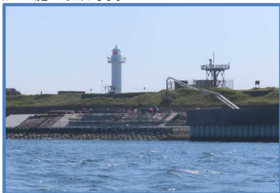
上部工施工状況
