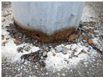
照明柱地際部の腐食と穴空き状況
