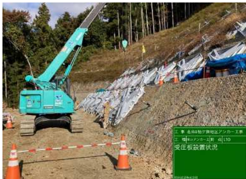
受圧板(二次製品)施工状況
