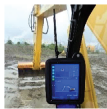
ICT建設機械の施工
