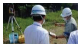
トータルステーション計測
