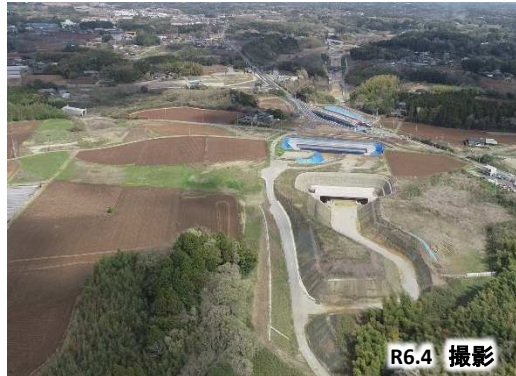
②清水地区 橋梁上部工事
