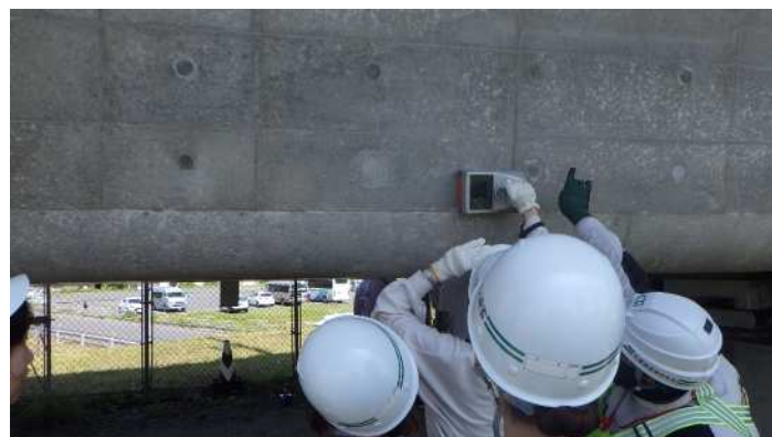
電磁波レーダーによる 鉄筋探査
