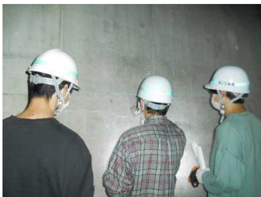
ひび割れ調査
