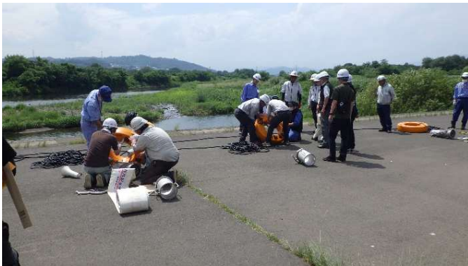
排水ポンプの組立訓練
