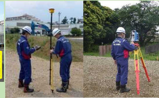
3次元計測機器による起工測量実習
