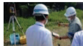
トータルステーション計測
