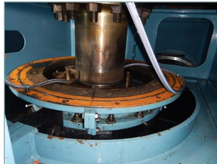
取付調整作業 完了
