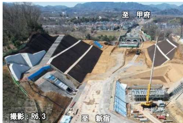
写真② 寺田地区改良工 状況
