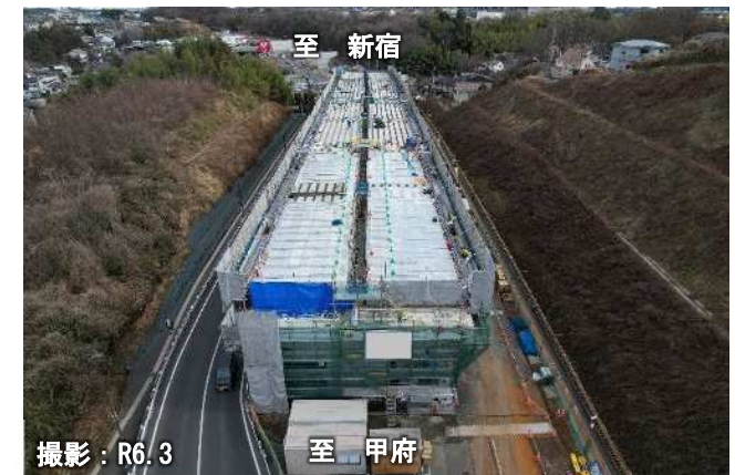
写真③ 大船寺田高架橋 状況
