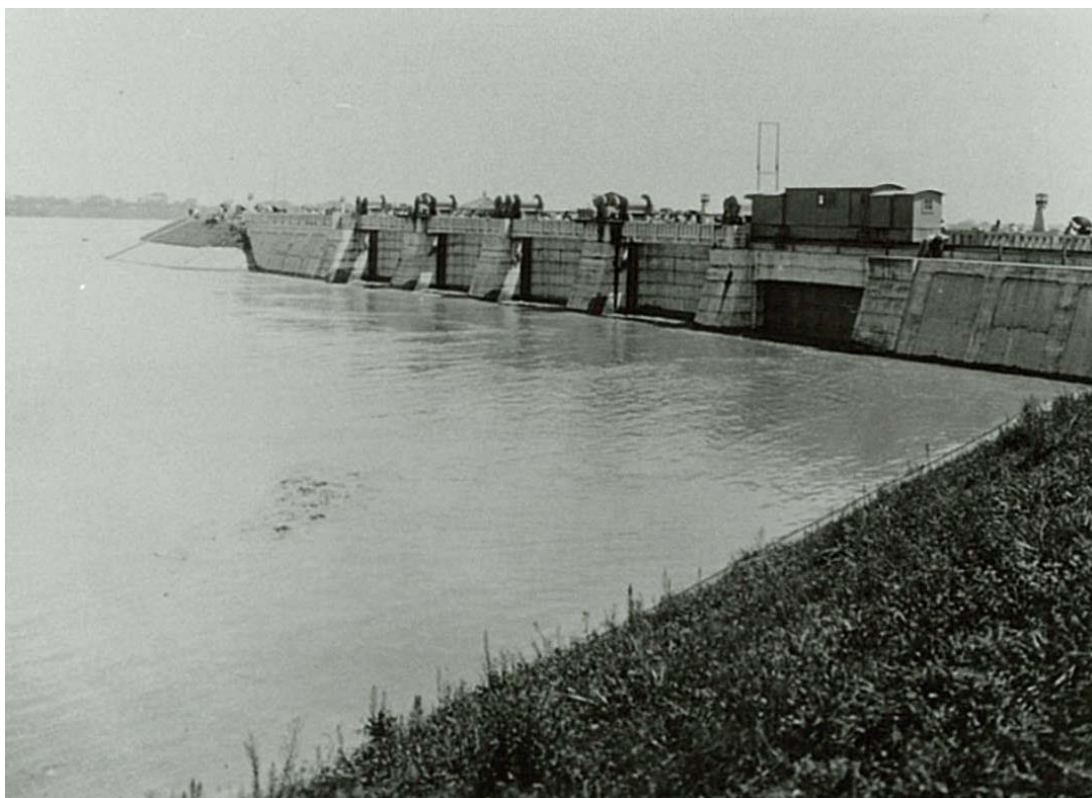
旧岩淵水門・完成直後（大正13年）
