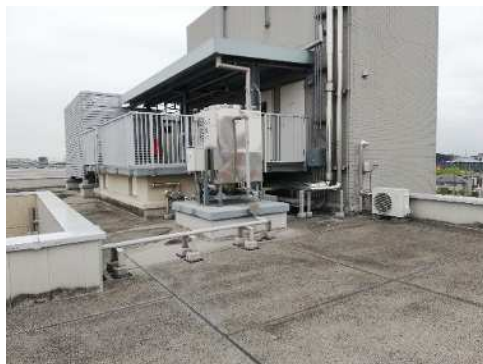
② 第1生徒寮屋上
