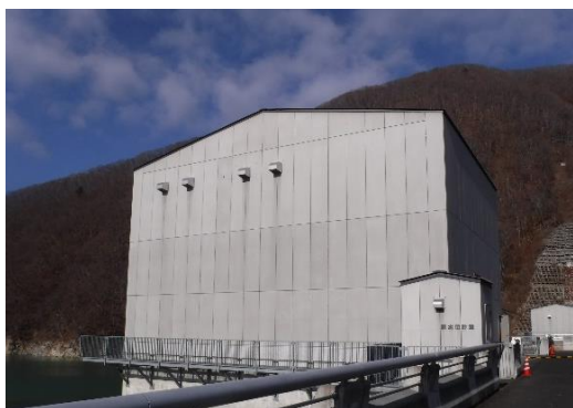
建物外部状況
