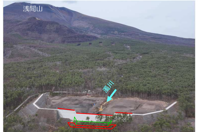
濁川第二砂防堰堤(施工中)
