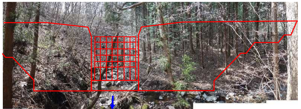
内手川第二砂防堰堤施工箇所
