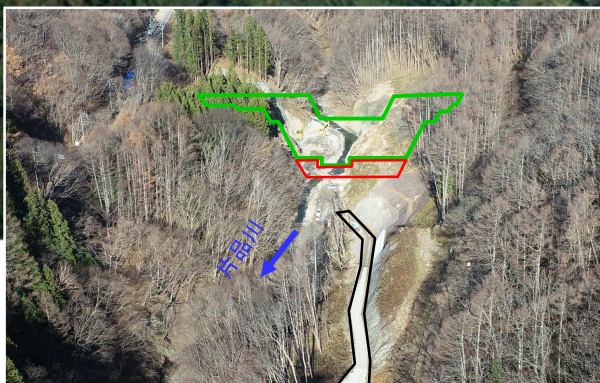
片晶上流第二砂防堰堤施工箇所
