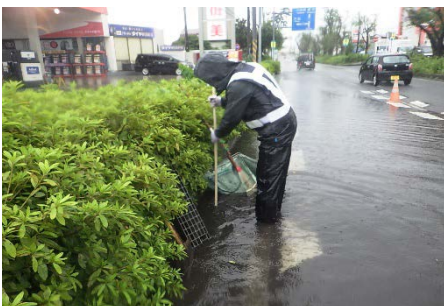
冠水処理 (国道1号)
