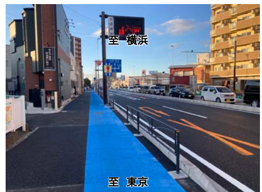
【歩道整備後の状況】 (歩道拡幅及び歩行者と自転車走行空間の分離) (川崎市幸区神明町下り線)
