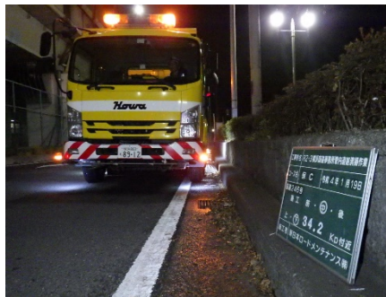
清掃 (路面清掃・排水施設清掃等)
