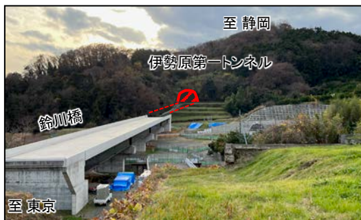
①【鈴川橋上部工(令和6年3月撮影)】
