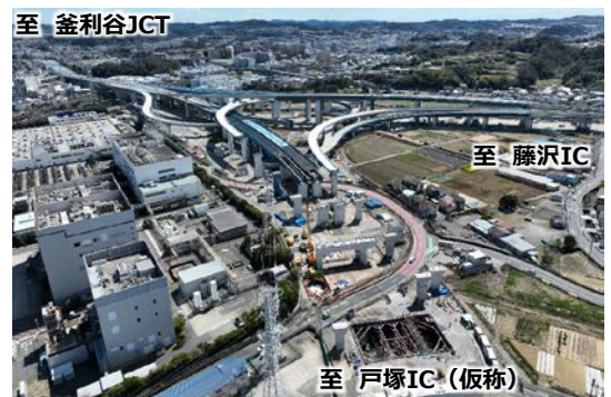
②【栄IC・JCT(仮称)付近状況(令和6年3月撮影)】
