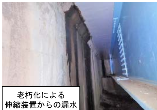
橋梁補修 施工前
