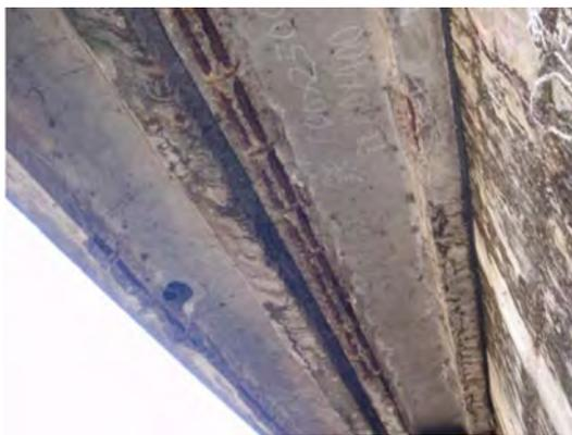
・主桁の腐食 <縦桁補修>
