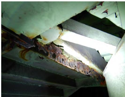
・地覆の腐食 <地覆補修>
