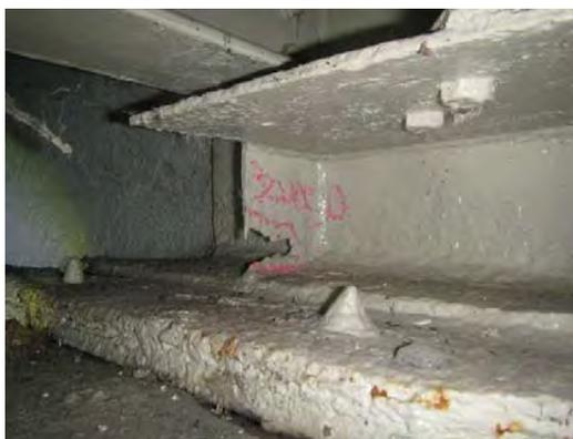
・横桁の腐食 <横桁補修>
