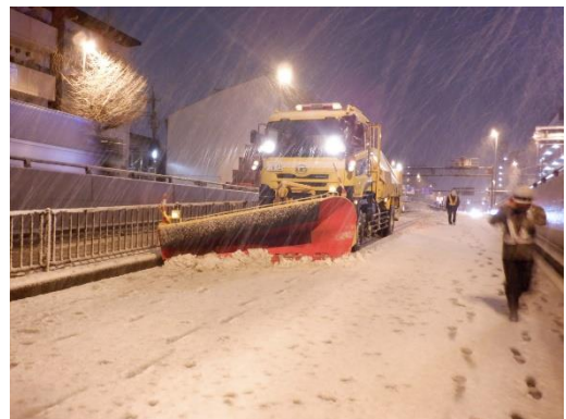
除雪作業（国道246号世田谷区瀬田）
