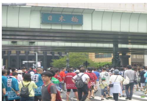
日本橋橋洗いを実施
