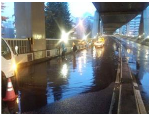
災害時の応急復旧（冠水処理）
