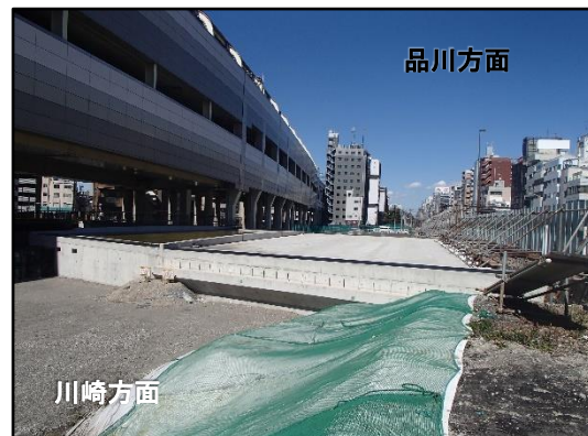
②夫婦橋の現況（令和6年3月撮影）
