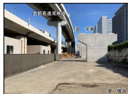
②有明立体予定地付近（令和6年2月撮影）
