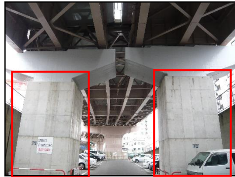
コンクリート巻立による橋脚補強
