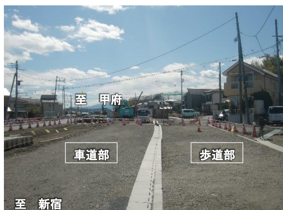
② 川辺堀之内地区改良工 川辺堀之内地区から甲府方向を望む (令和6年3月撮影)
