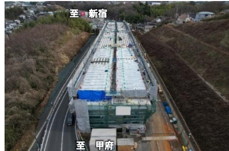
②大船寺田地区側道橋 寺田地区から新宿方向を望む (令和6年3月撮影)
