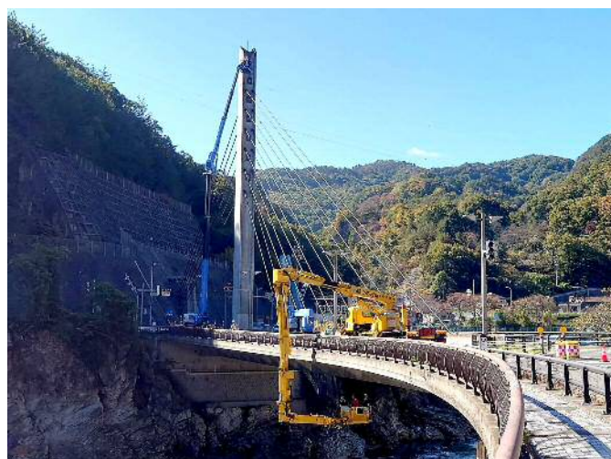
りょうぐんばし 国道19号両郡橋点検状況(遠景)
