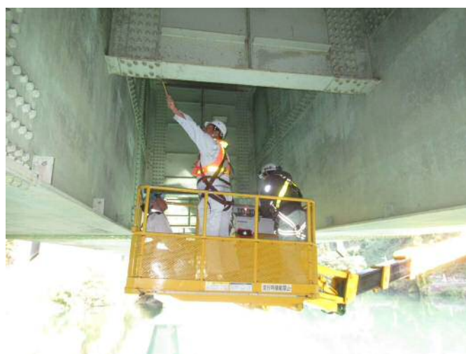
だいあんじはし 国道19号大安寺橋点検状況(近景)
