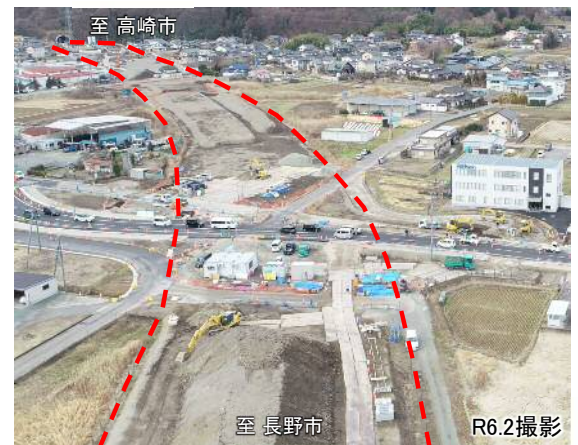
ながの しおざき 長野市塩崎地区の工事状況
