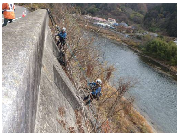
おおまちやさか 国道19号大町市八坂地内点検状況
