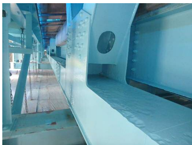
ほかり 国道19号穂刈橋塗装作業状況
