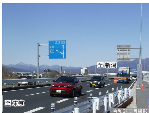
①国道17号・18号合流部（拡幅区間）
