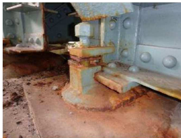
— よし の さわばし 吉野沢橋（支承補修） —
