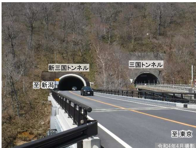
①新三国トンネルの状況
