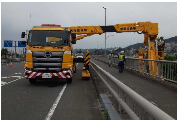
橋梁点検車による点検状況（ ひさよしばし 久芳橋（下り））
