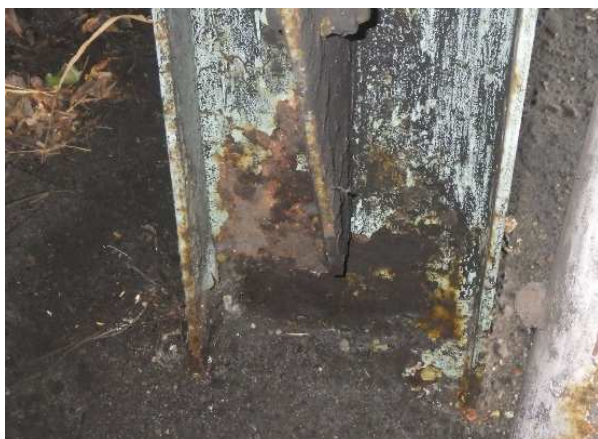
— しぶかわかみしろ い あや ど 渋川上白井綾戸（柱基部補修） —
