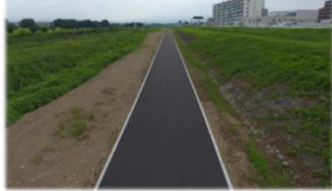
完成した管理用道路の状況 (H29.8)
