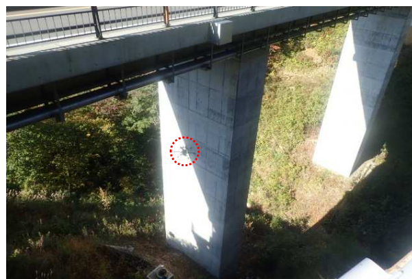
点検支援技術(UAV)を活用した橋梁点検状況（ しんじょうえつばし 新上越橋）
