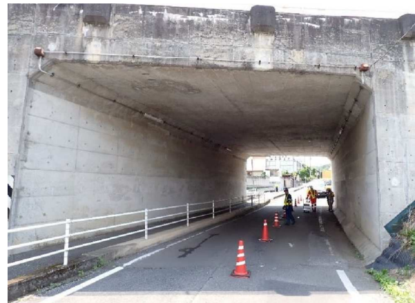
— きりゆう ひろ さわちよう 桐生市広沢町（ひび割れ補修） —
