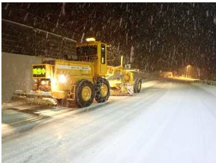
除雪作業状況
