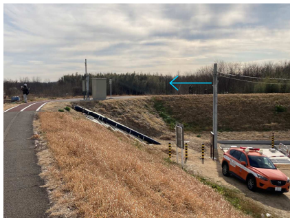
かん な がわ 神流川左岸0.0k付近
