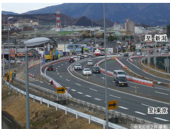
① 渋川市中村の施工状況
