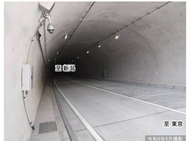
②新三国トンネル内部の状況
