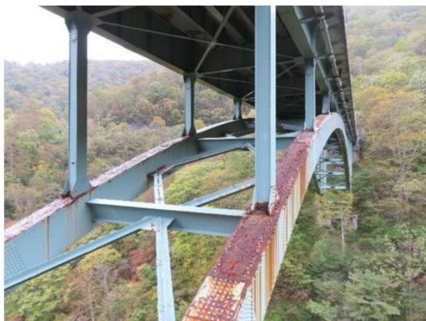
— み さか おおはし 三坂大橋（アーチ部材補修） —
