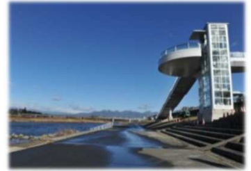
桜観音橋 (人道橋)
