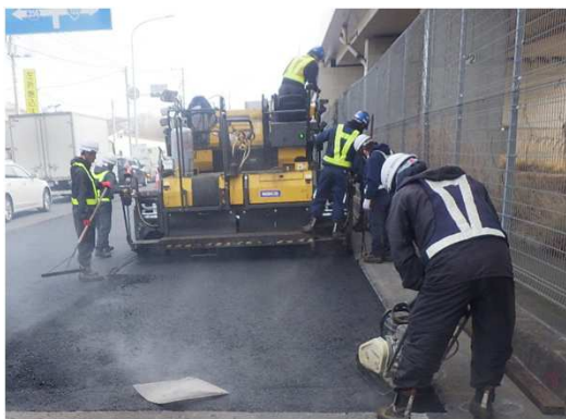
舗装補修状況
