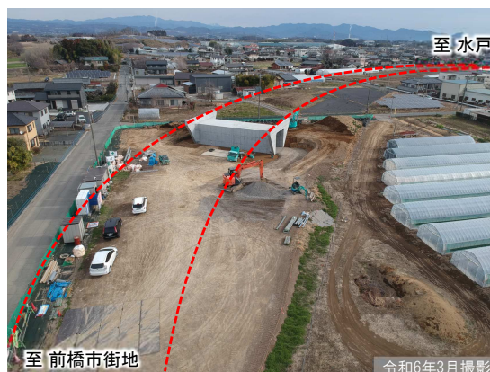
②赤堀今井町地区の工事状況
