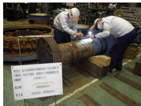
主ポンプ分解補修
