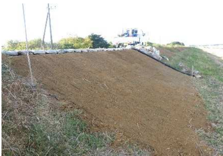
法面補修状況
