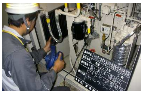
電気設備点検状況
