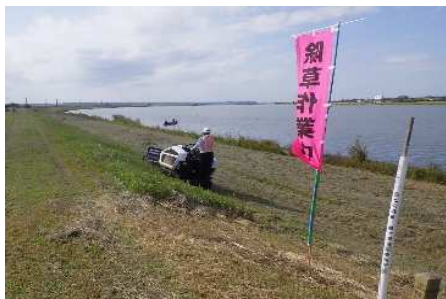
堤防除草状況
