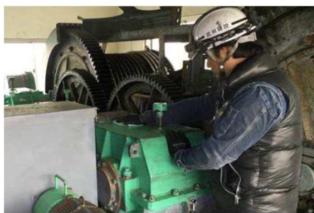
機械設備点検状況
