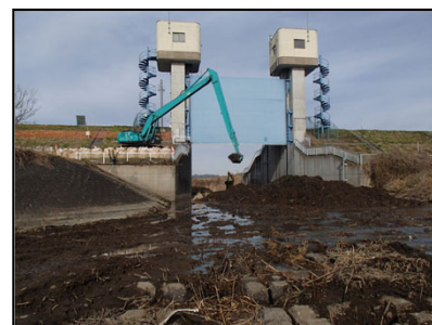
【管内全域】維持管理(例) 水門水路の土砂等撤去作業
